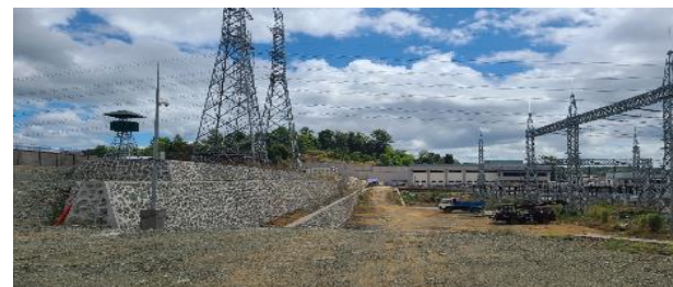
トランスミッションタワー クレーン
