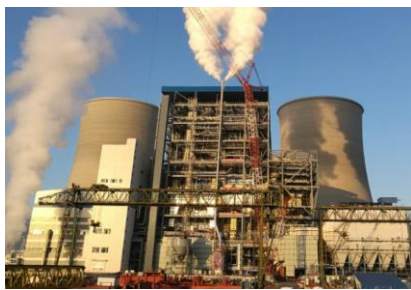
発電所ボイラー
