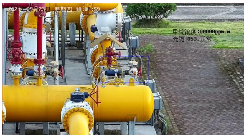
安徽省LNG基地プロジェクト
