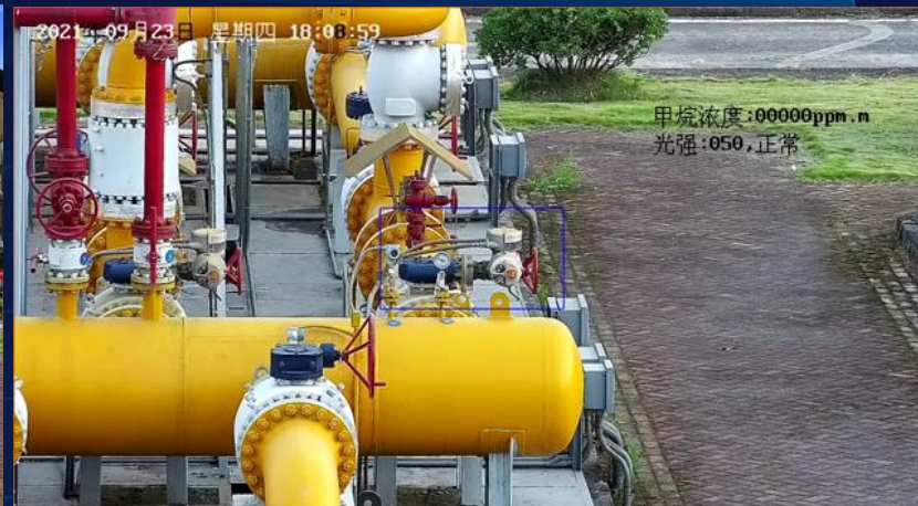
安徽省LNG基地プロジェクト
