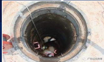
地下トンネル
