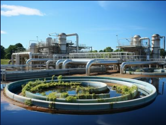
水道関連設備の監視
