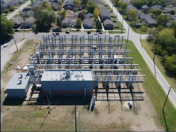
電気設備のメーター監視
